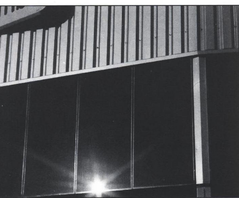
Zasilanie energią słoneczną obiektów przemysłowych - źródło pomocnicze
